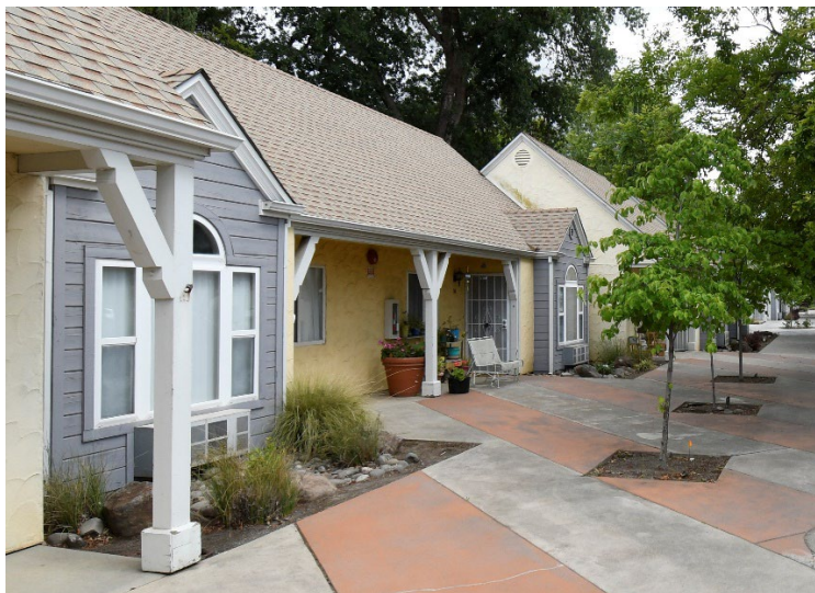
Walker Commons Apartments, Chico
